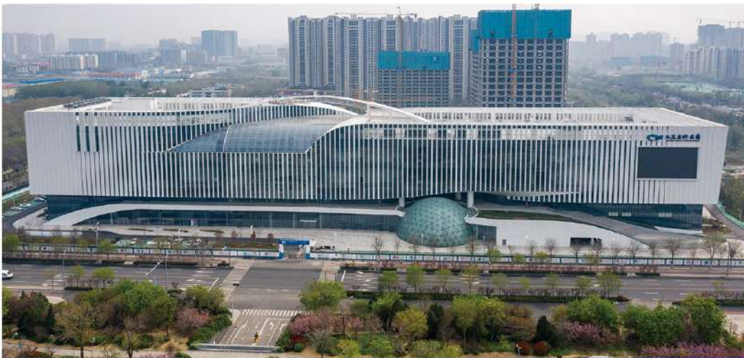
山东省科技馆项目装饰装修
